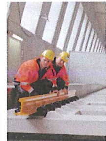
Die ersten Gleise wurden bereits in den Tunnels verlegt. Foto: Wenz
